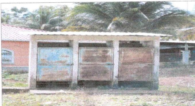
Foto 3: Cambios de puertas de sanitarios, estan en mal estado en modulo 1
